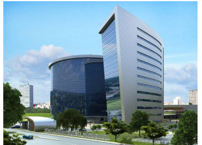
DSİ Genel Müdürlüğü | Yangın Kapısı
